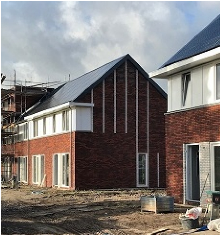
Nieuwbouw in uitvoering, Gorecht West in Hoogezand
