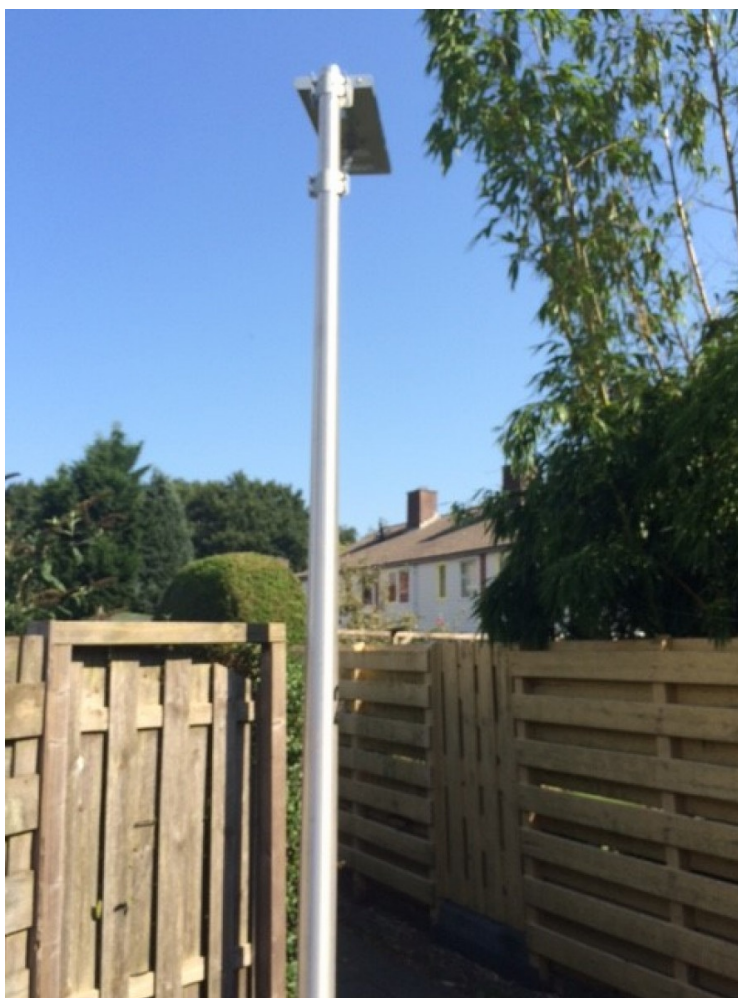
Aanleg achterpadverlichting Emmermeer
